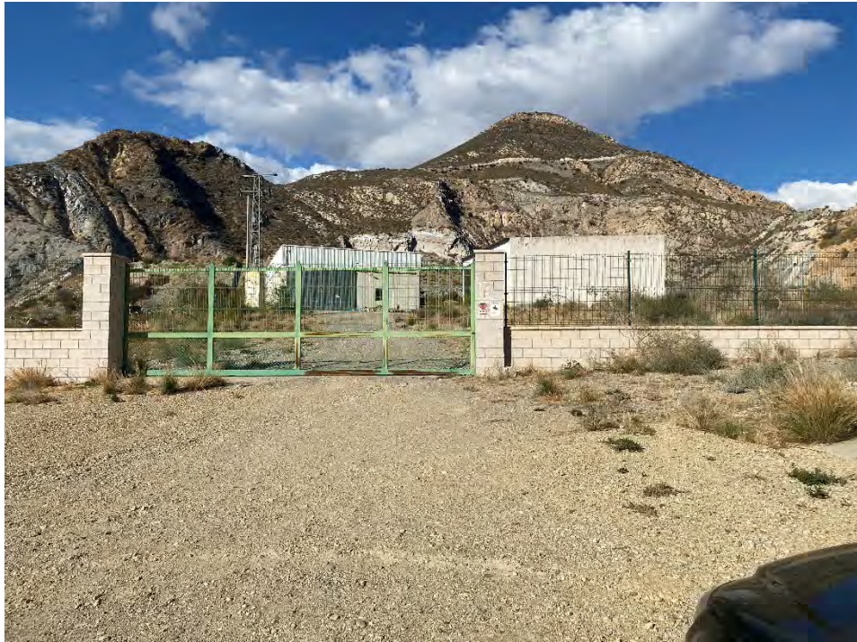
Fotografía 3: Puerta y vallado de protección de las instalaciones relativas a la Balsa Abellán
