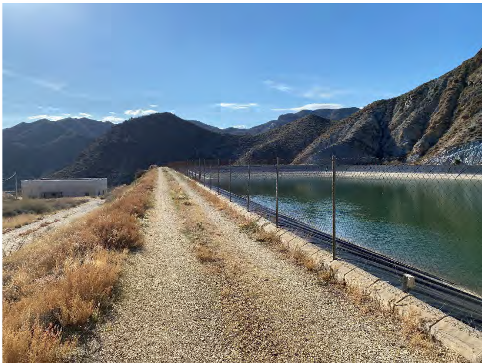
Fotografía 2: Pasillo de coronación de la Balsa Abellán
