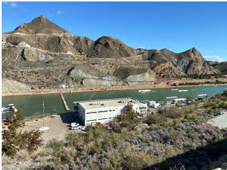
Fotografía 4: Vista general del trazado de la LMT
