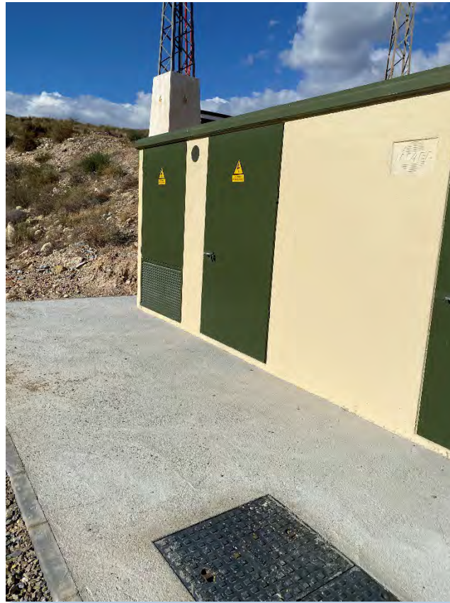
Fotografía 5: CT Existente. Punto de entrega de energía de la LMT proyectada
