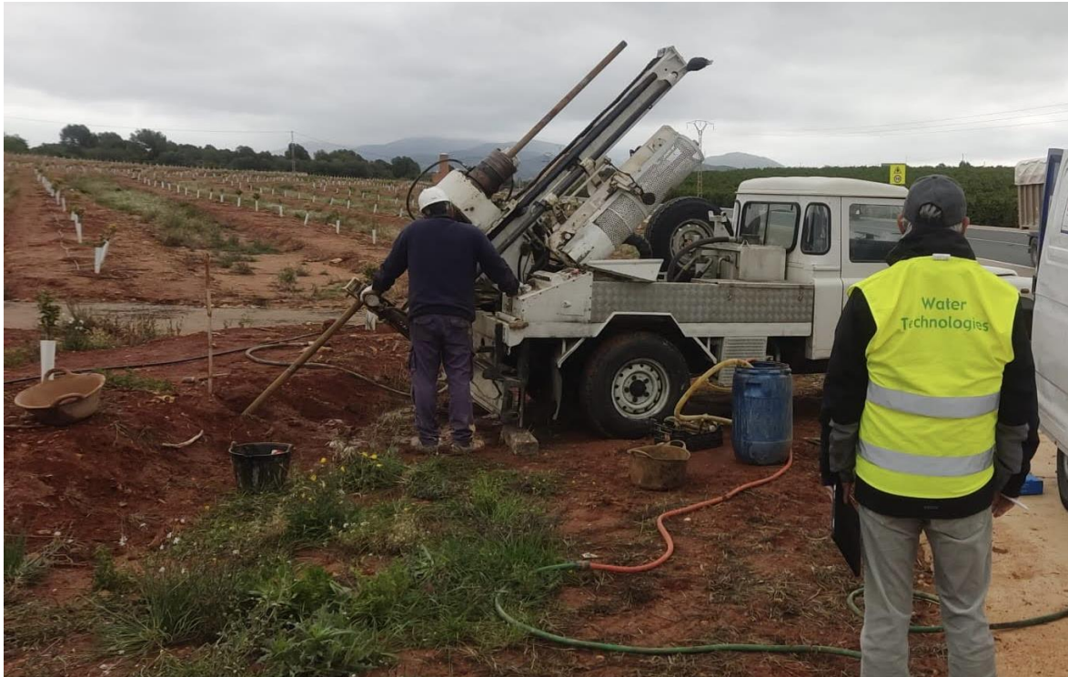
Figura nº 4. Detalle de instalación del dispositivo de control del lixiviado
