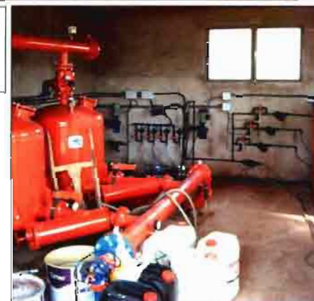
Detalle del riego por goteo, microaspersor y caseta de riego (filtros, tanques fertilizantes, bomba de fertirrigación, etc.)
