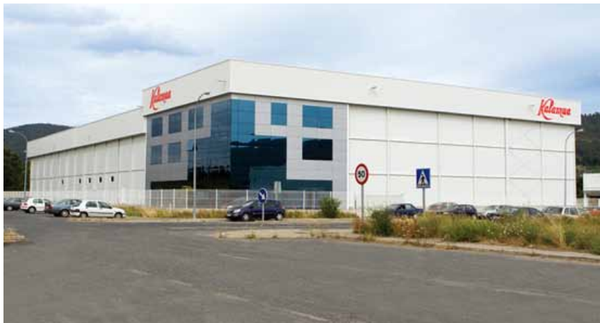
Instalaciones de Monte Kalamua.
