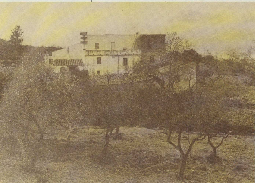
En una primera fase, está previsto acondicionar la masía existente para destinarla a albergue, merendero y aula de la naturaleza y talleres.
