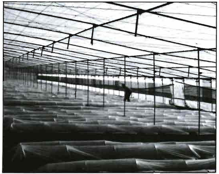
Con el uso de láminas de Copolímero EVA CP-636 en la construcción de pequeños túneles en el interior de invernaderos, los cultivos reciben mayor luminosidad.
