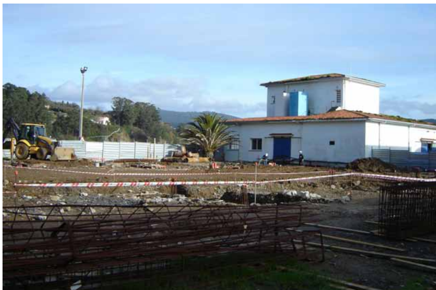
Obras de ampliación de la lonja de Cedeira.
