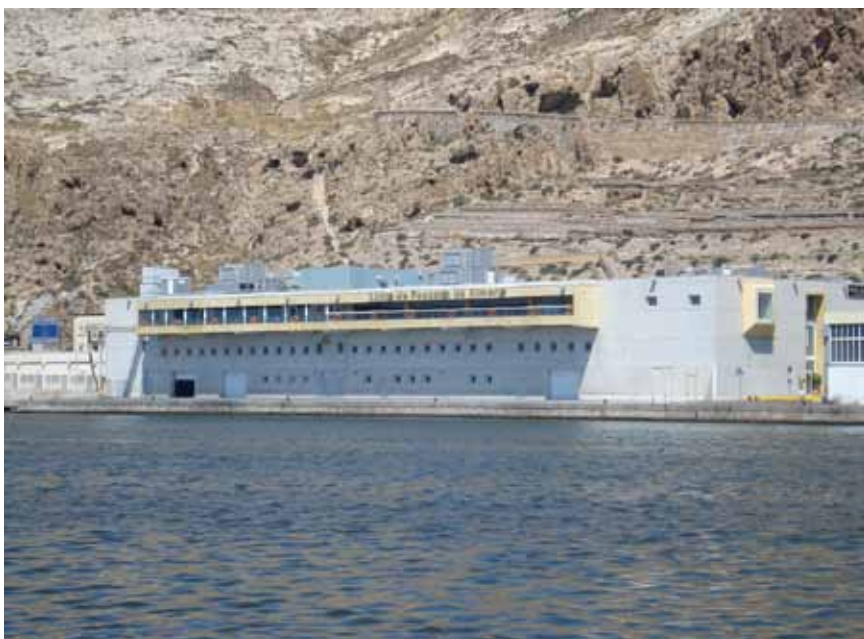
Instalaciones la lonja de pescado de Almería.
