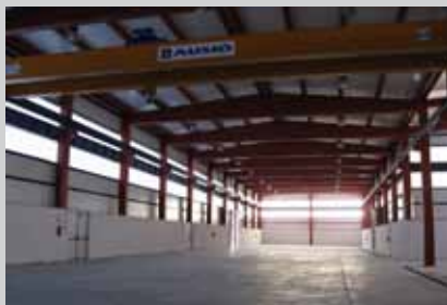
Interior de la nave para reparación de redes.
