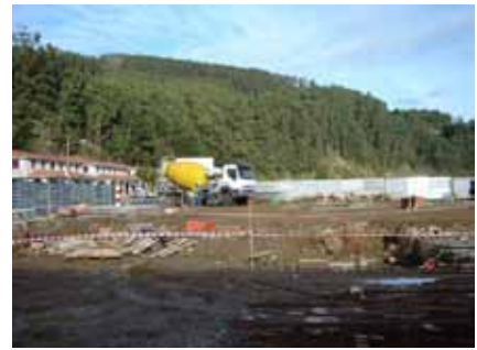
Obras de ampliación de la lonja de Cedeira.
