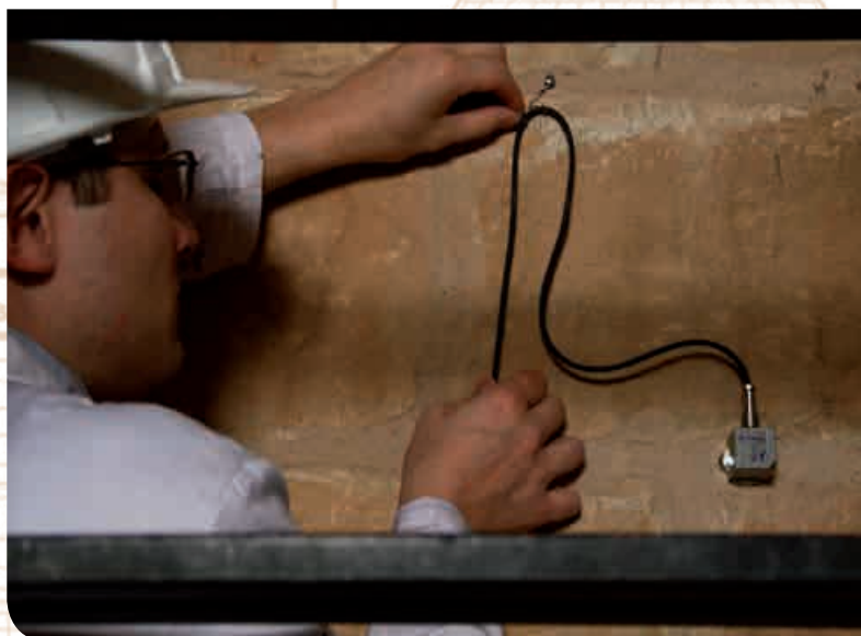
Técnico de la Fundación Santa María la Real instalando un acelerómetro triaxial en uno de los paramentos del templo. Este dispositivo mide vibraciones estructurales.
