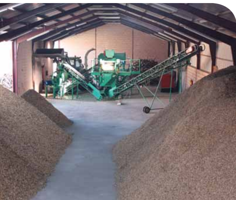
■ Nave del Centro de Producción y Logística de Biomasa en Lozoyuela (Madrid).
