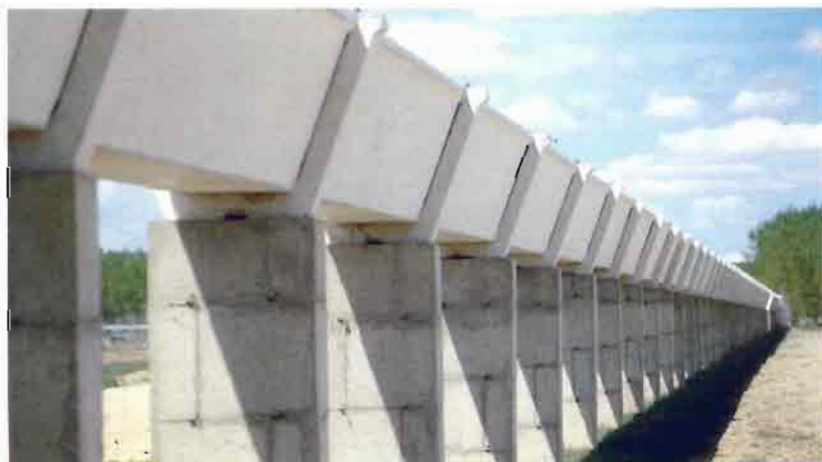
Fig. 4.-Acequia elevada: detalle de los pilares de sustentación.
