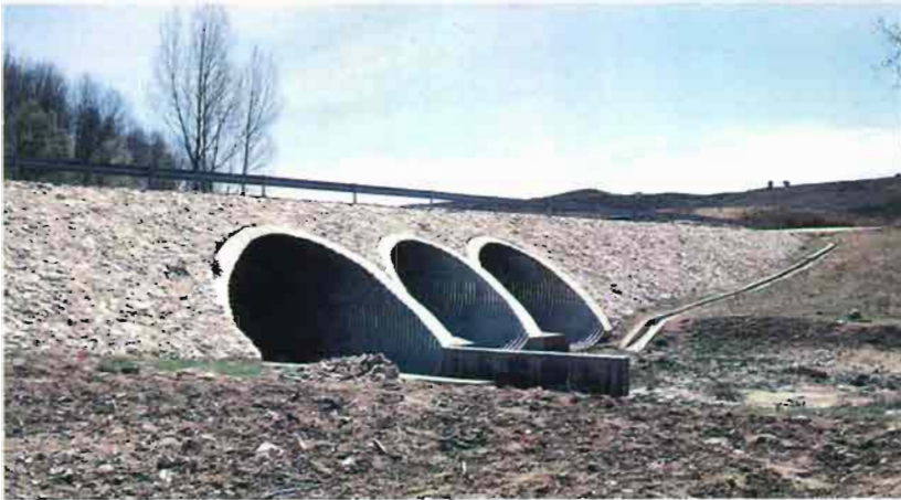
Fig. 16.–Puente sobre un camino integrado «ambientalmente».
