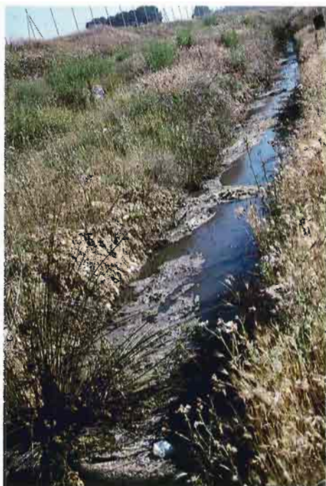
Fig. 13.-Desagüe de zona regable, en el que se aprecia el mal estado del agua.
