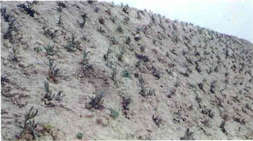
Fig. 18.–Talud artificial, repoblado para su protección.
