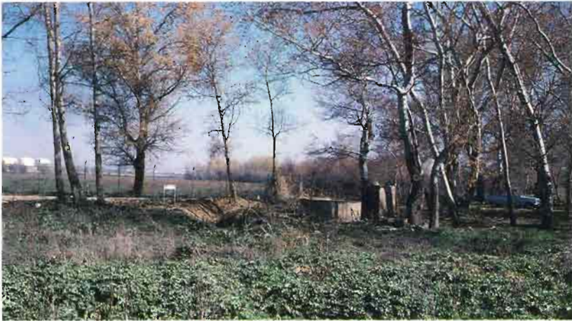
Fig. 14.–Obras relacionadas con regadíos abandonados.
