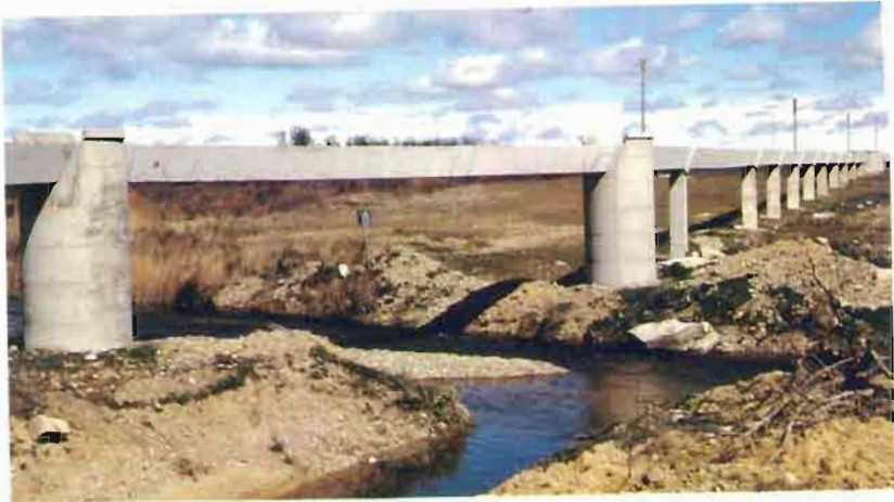
Fig. 3.-Acequia elevada para riego por gravedad: detalle del paso de un riachuelo.
