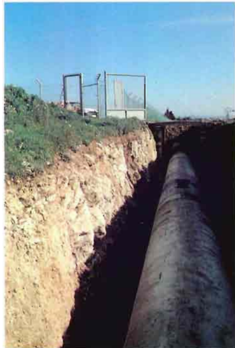
Fig. 20.-Colocación de tubería para su posterior tapado.
