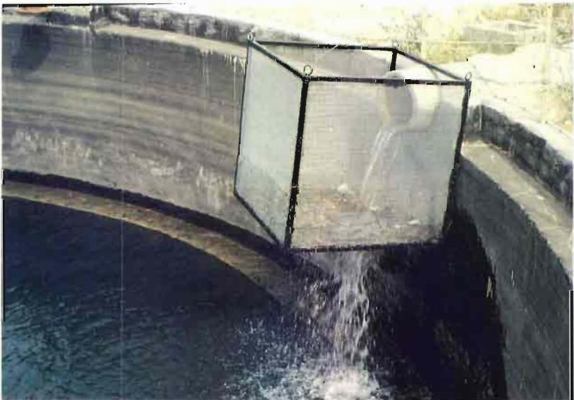
Fig. 2.- Prefiltro antes de la entrada del agua al embalse que retiene partículas y materiales en suspensión.
