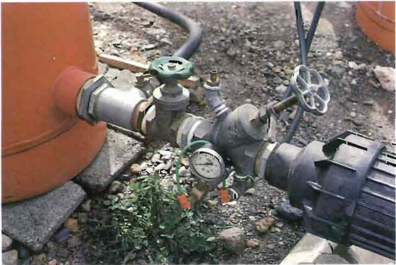
Fig. 19.–Se observa a la derecha un filtro de anillas. En el centro, una válvula de retención, manómetro y tubería que invierte el flujo del agua para lavado del filtro de arena situado a la izquierda.
