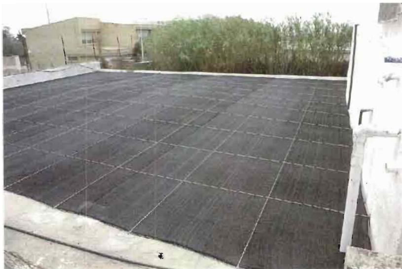
Fig. 21.–Al cubrir la balsa se evita, entre otros, la formación de algas.
