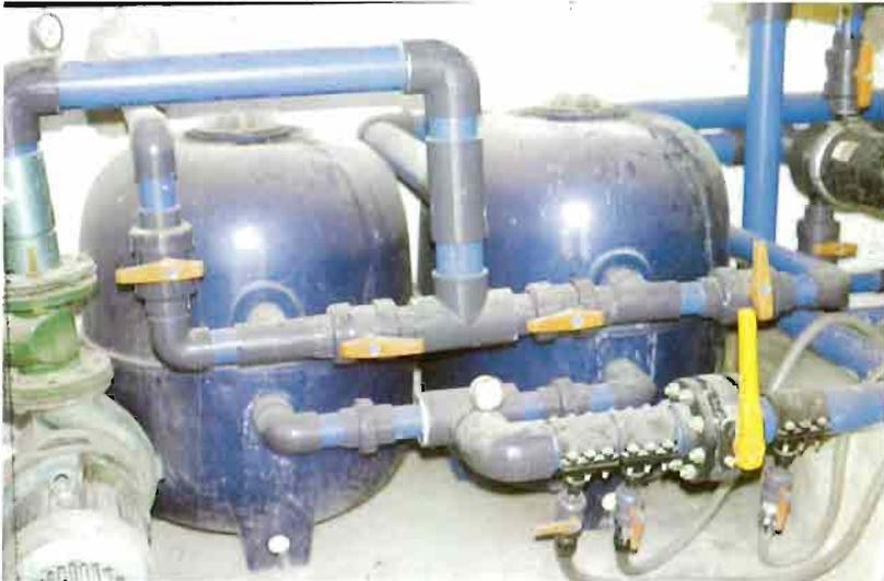
Fig. 4.-Batería de filtros de arena. Se observa detalle conexiones a la red de riego.
