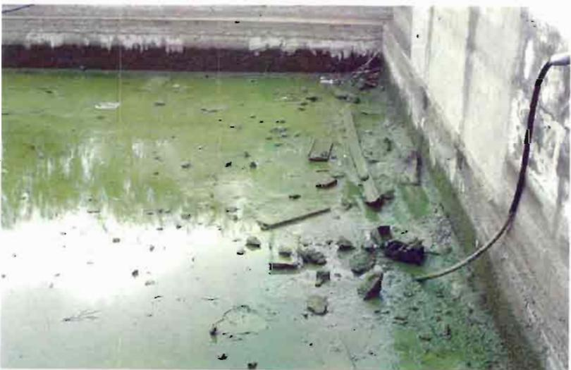
Fig. 22.–Si no se previene en los embalses se acumula suciedad y elementos sólidos.
