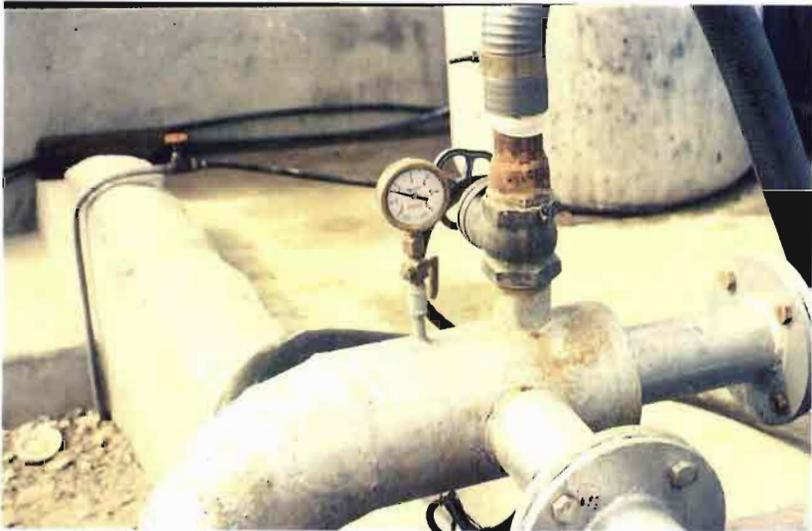
Fig. 18.-Los manómetros nos indican la presión de trabajo en la red.
