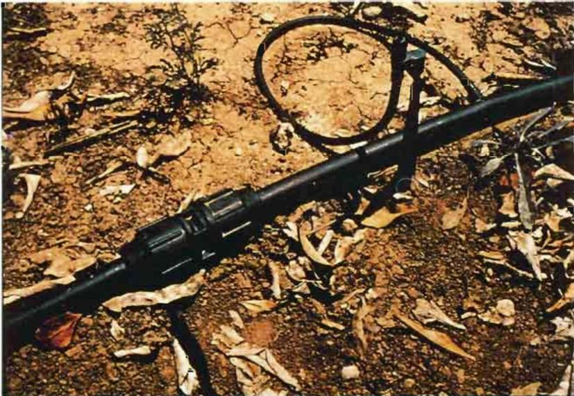
Fig. 11.-Unión de tubería de polietileno mediante manguito exterior de plástico.
