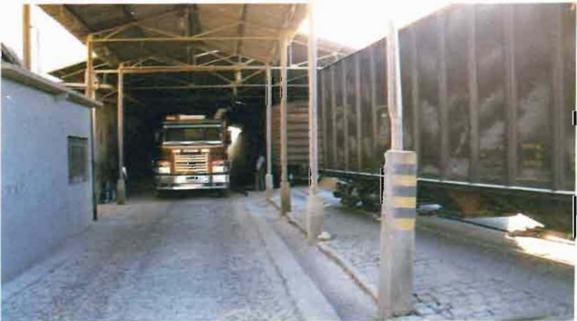
Fig. 3.-Instalación de carga de aprovisionamiento doble para camión y ferrocarril.
