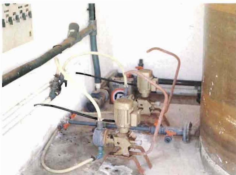
Fig. 9.—Inyectores de fertilizante en la tubería de riego.
