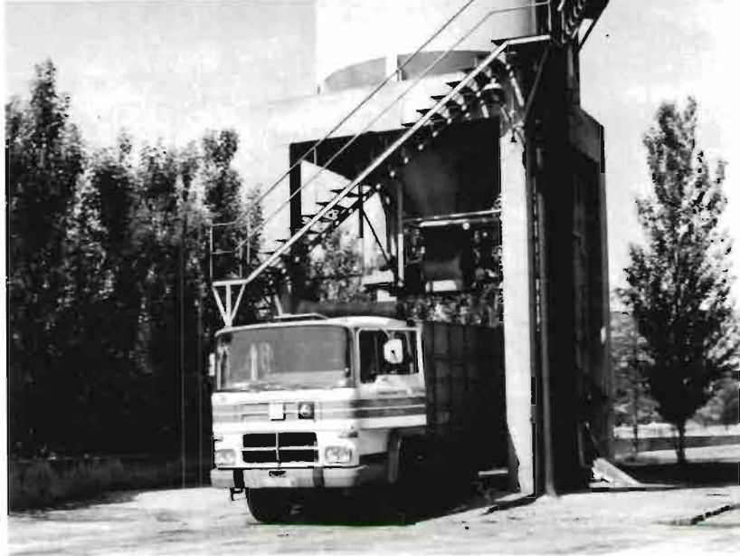
Fig. 5.—Depósito para carga de camiones.
