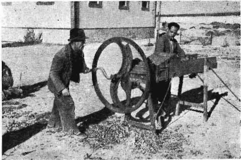
Fig. 4.—Obreros troceando sarmientos de vid con un cortaforrajes accionado a mano.
