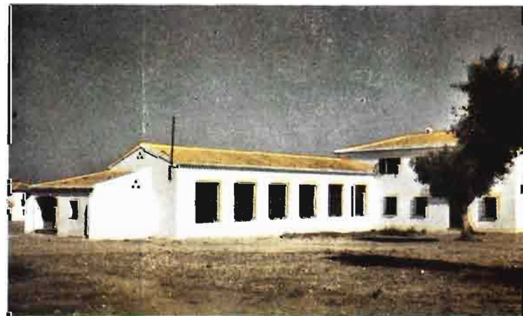
Escuelas y viviendas de maestros en Lachar (Granada).
