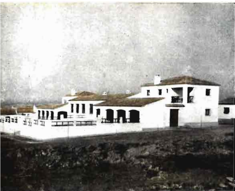
Escuelas del nuevo pueblo de Suchs (fachada posterior).
