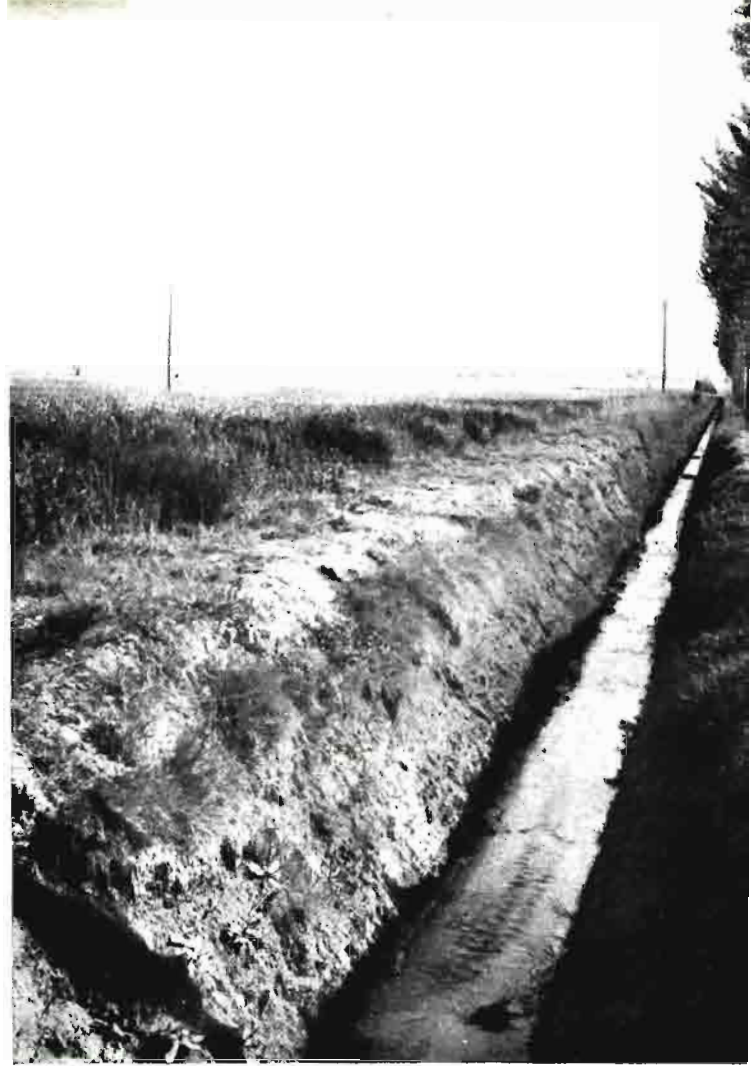
Uno de los desagües de saneamiento.
