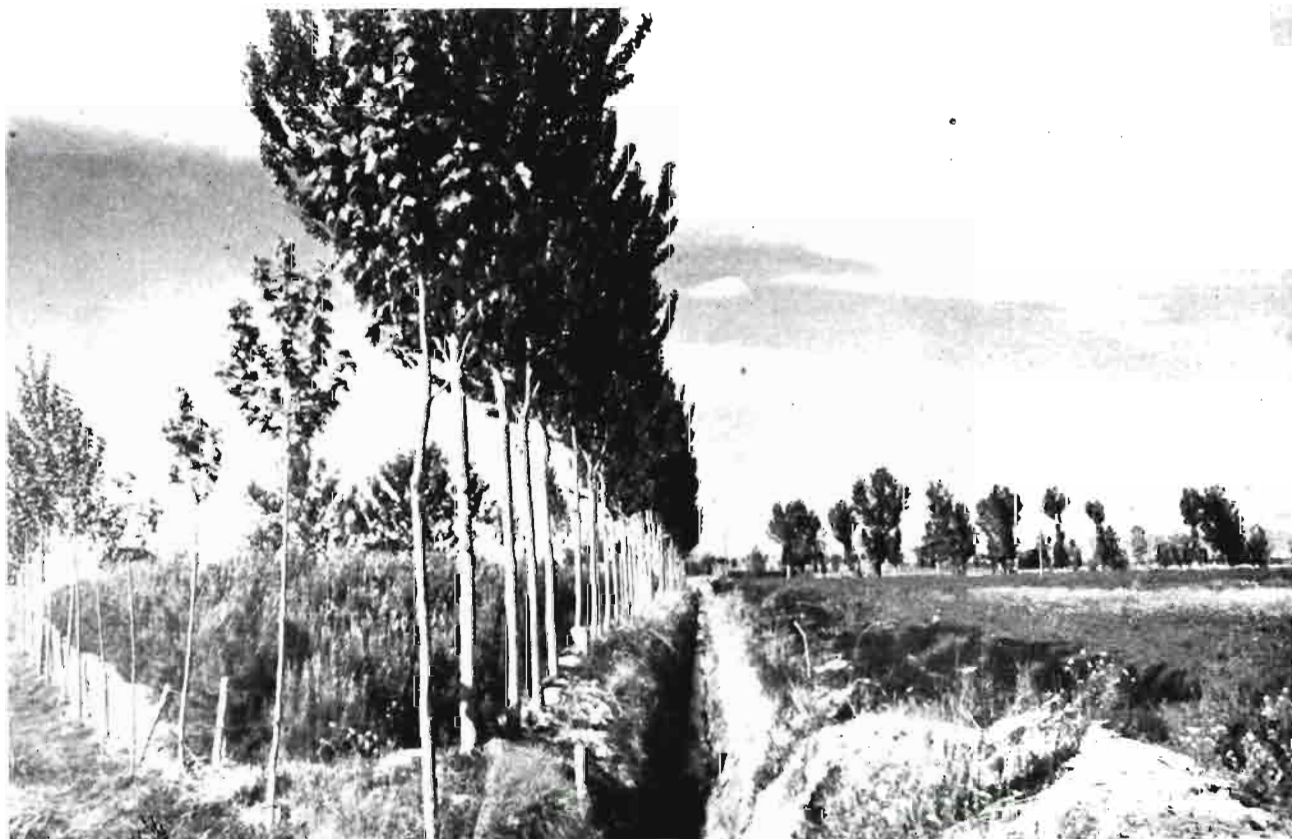
El I. N. C. evita el paludismo sancando el terreno por medio de desagües.
