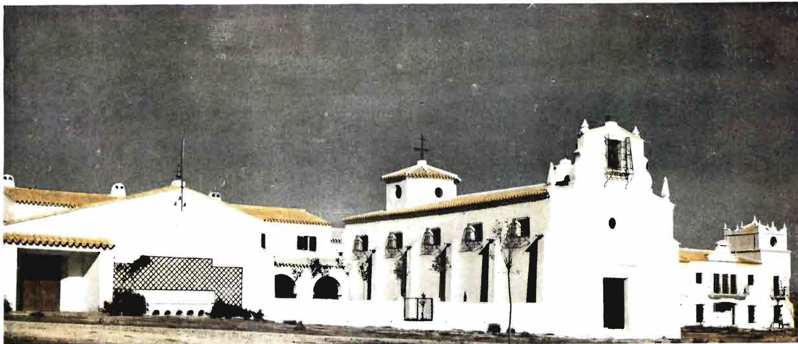
Iglesia del nuevo pueblo de El Torno (Zona del Guadalecín).
