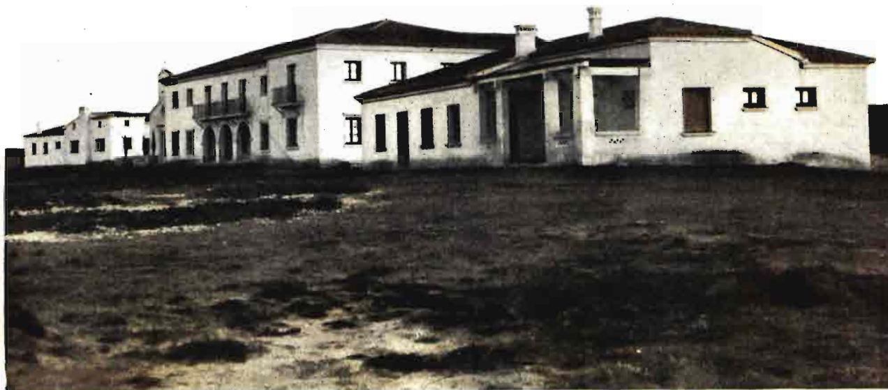
Centro de Colonización del Gaudiana y Escuela de regadores en la finca La Orden (Badajoz).
