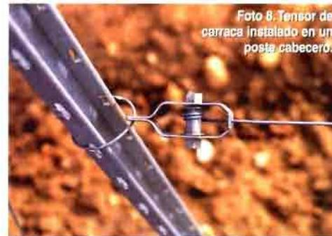
Foto 8. Tensor de carraca instalado en un poste cabeceero.
