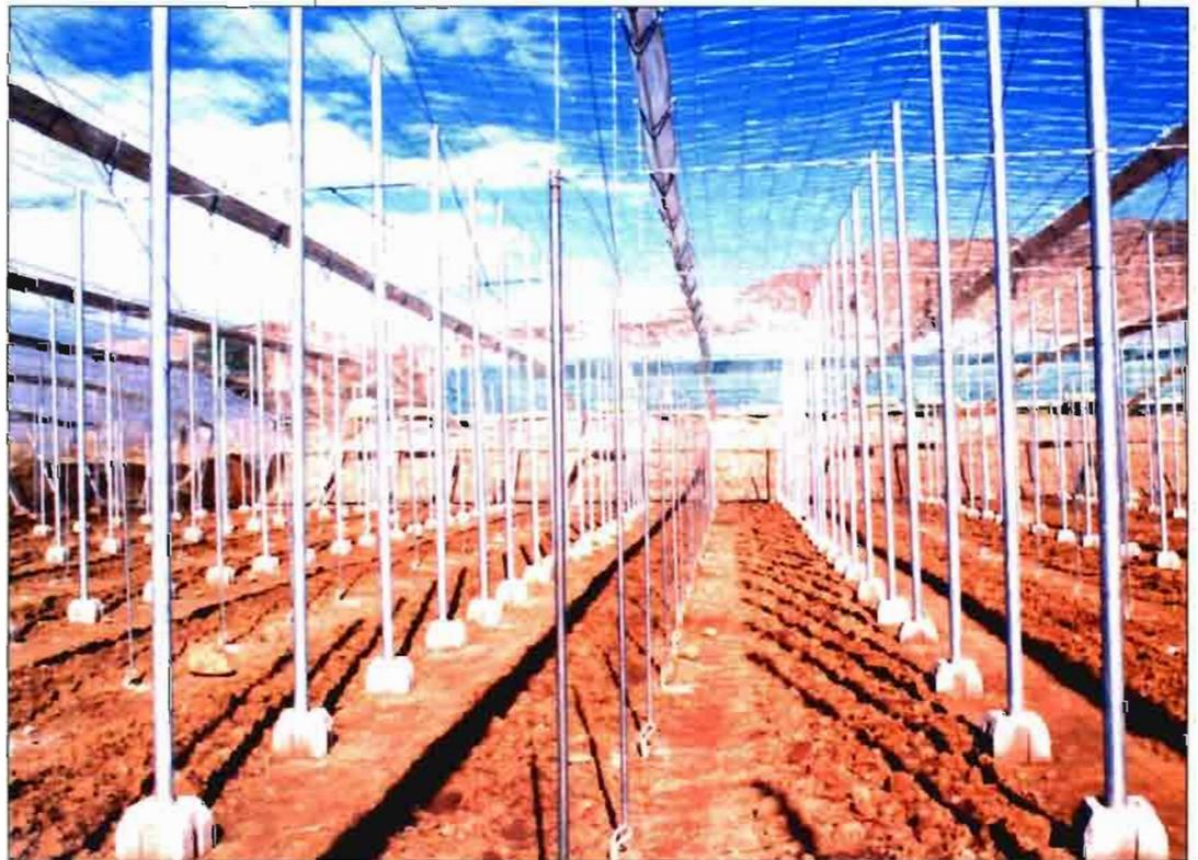
Foto 1. Estructura de un invernadero tipo Almería.
