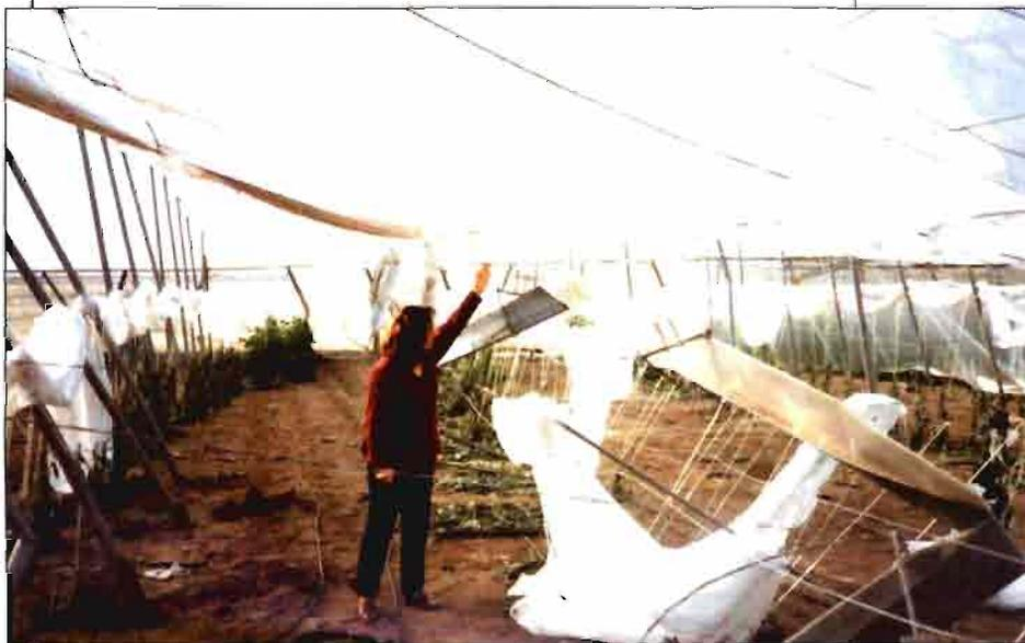
Foto 2. Colapso de la estructura por la acción del viento.
