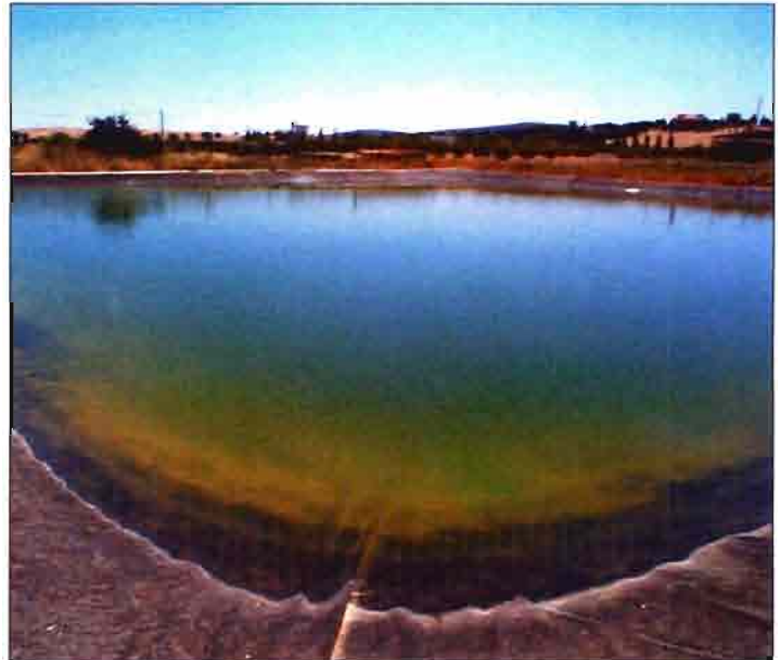
Balsa de regulación para garantizar el suministro de agua de riego.
