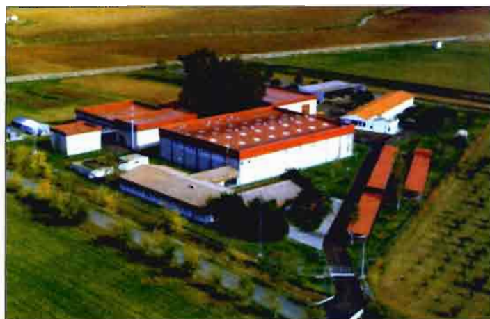
Vista aérea del Centro Tecnológico Agroalimentario de Extremadura.
