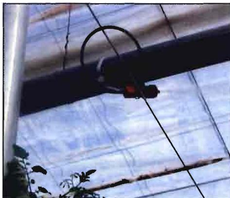
Figura 11. Sistema fijo de nebulización.
