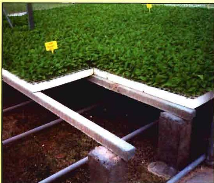
Figura 6. Calefacción por agua caliente.
