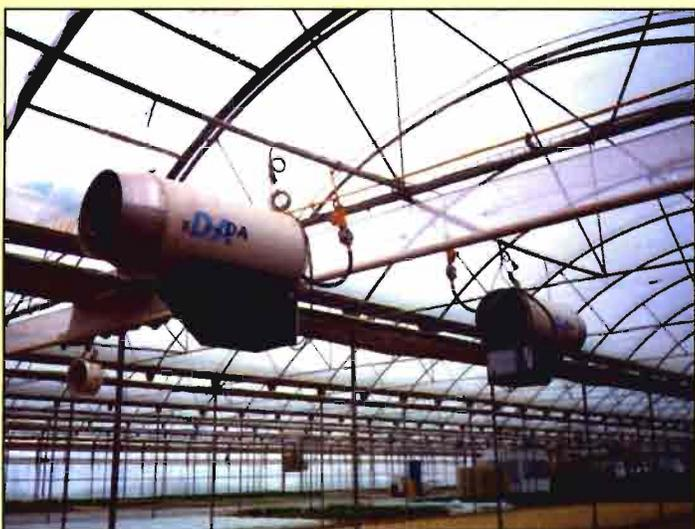
Figura 7. Generadores de aire caliente de combustión directa.
