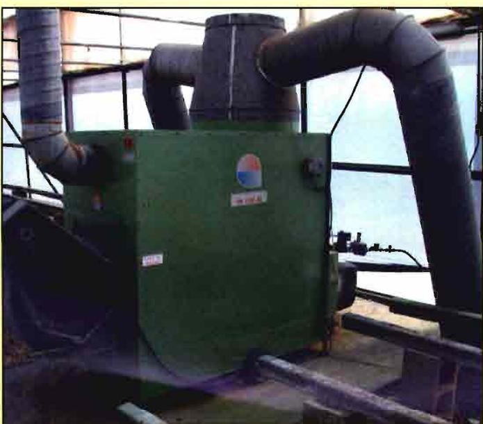
Figura 8. Generador de aire caliente de combustión indirecta.
