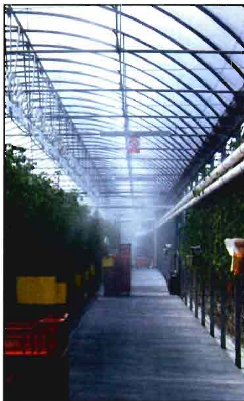
Figura 9. Invernadero con el sistema de nebulización activado.
