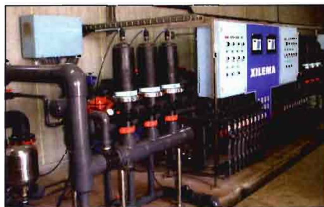
Figura 2. Equipo de fertirrigación.
