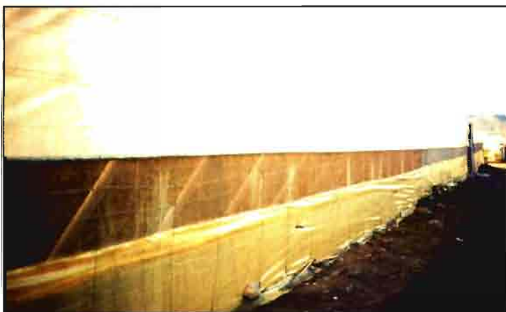
Utilización de mallas para sellar la superficie de ventilación.
