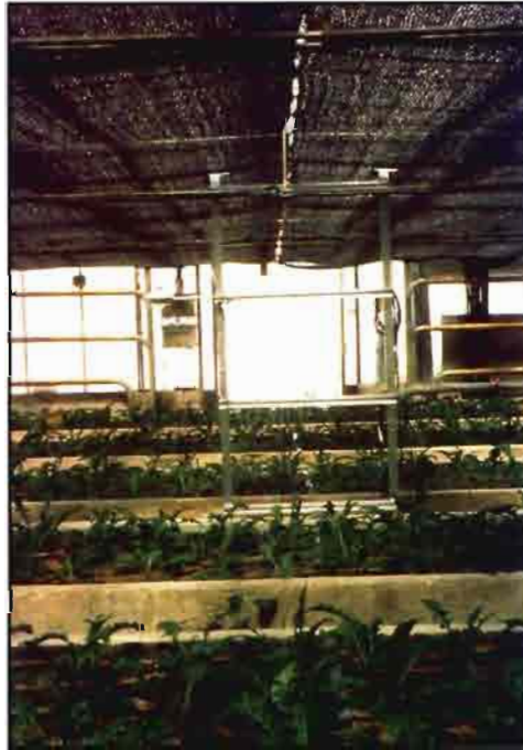
Ventilación cenital en invernadero Venlo (Holanda).
