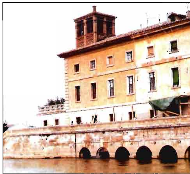
El Bocal. Casa de compuertas del Canal Imperial de Aragón.
