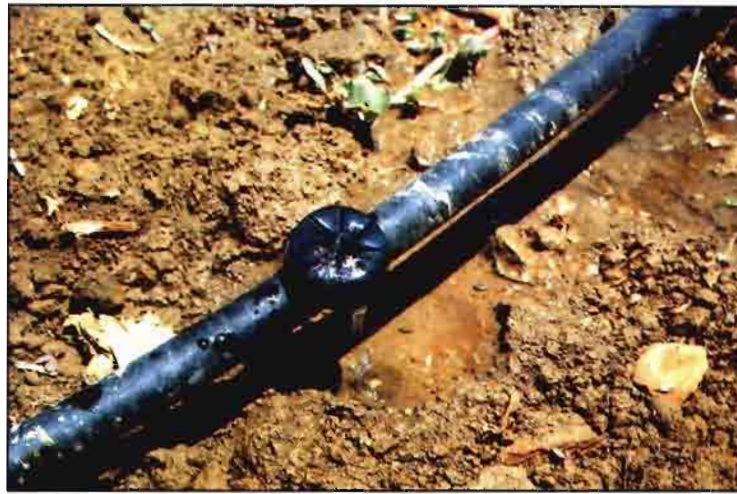
Detalle de gotero autocompensante con caudal 4 l/ha muy utilizado en las instalaciones de riego por goteo en la comarca.
