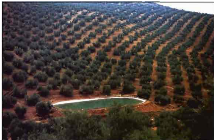
Es frecuente la construcción de balsas para acumulación de agua para el riego en verano, ya que en esa época está prohibida la captación de agua de los ríos.
