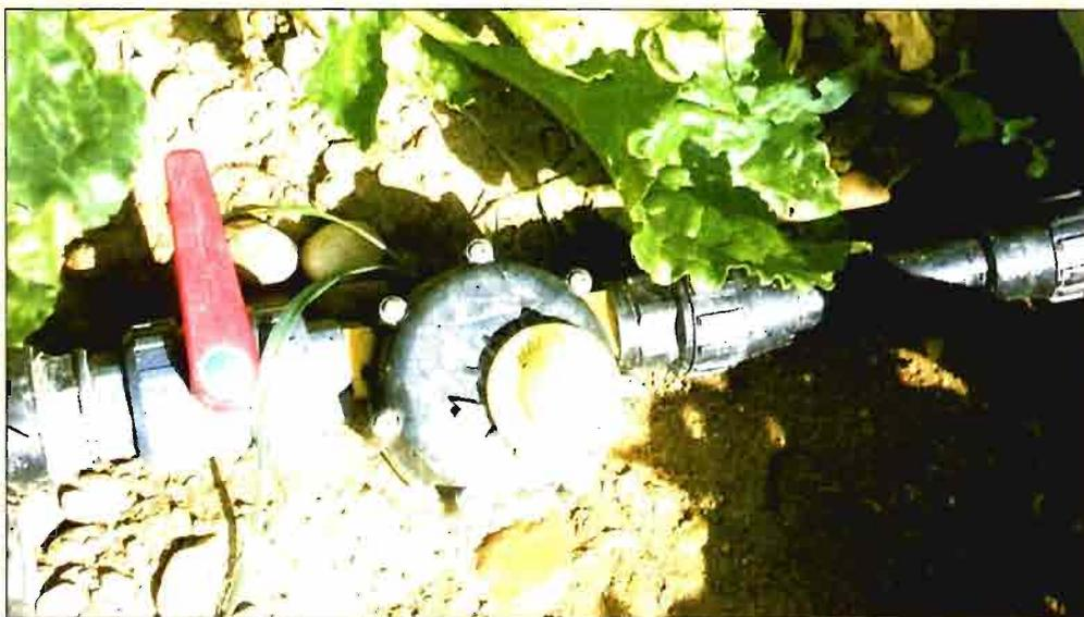
Contador volumétrico utilizado en riego por goteo de remolacha.
