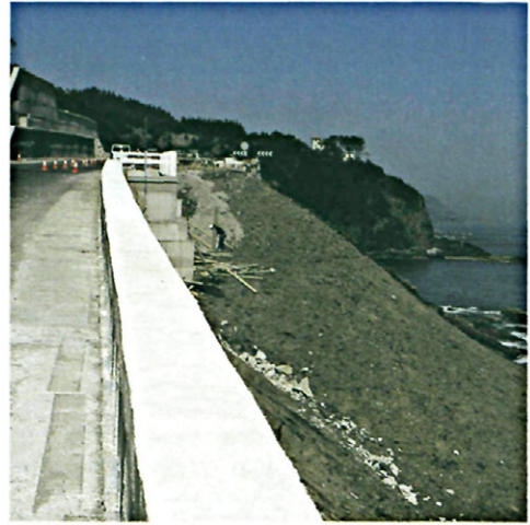
Fig. 9.—Aspecto actual de una zona que estaba ocupada por varios ejemplares de vid silvestre tras las obras de consolidación de la carretera costera.
