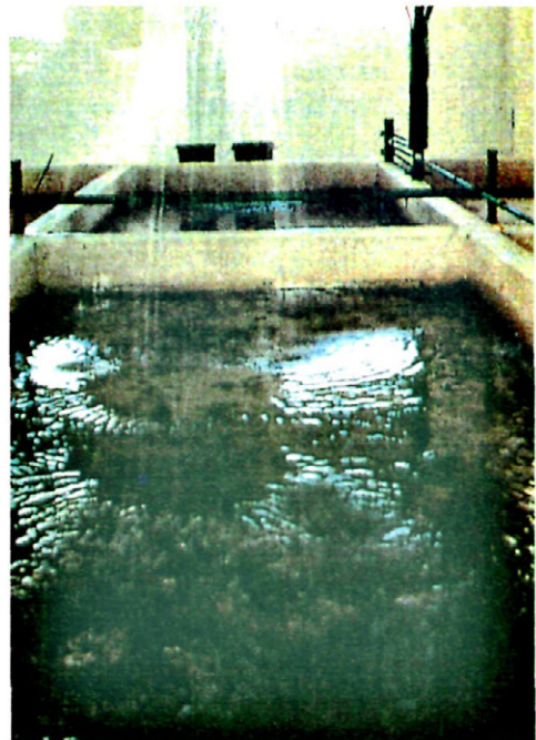
Fig. 3.—Estanques de depuración.
