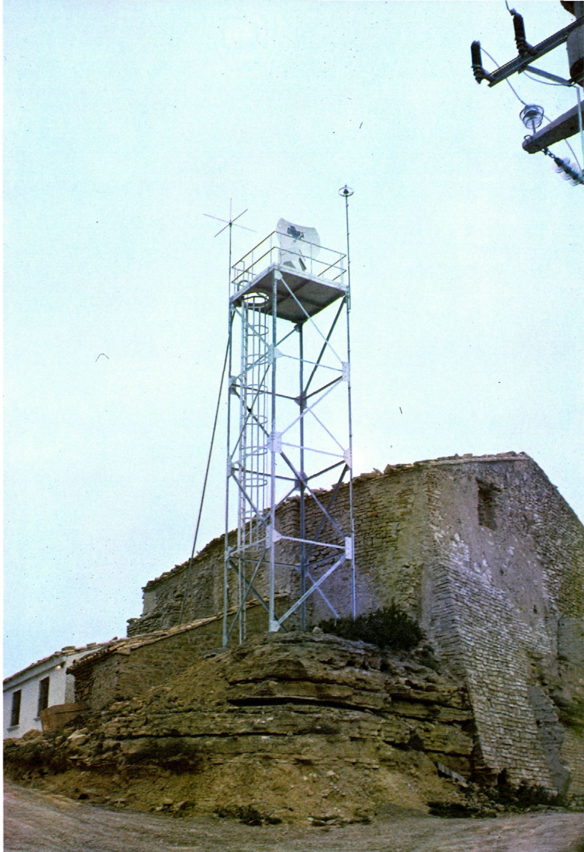
Fig. 3. —Rádar para seguimiento de tormentas instalado en Monte de San Caprasio (Alcubierre).
