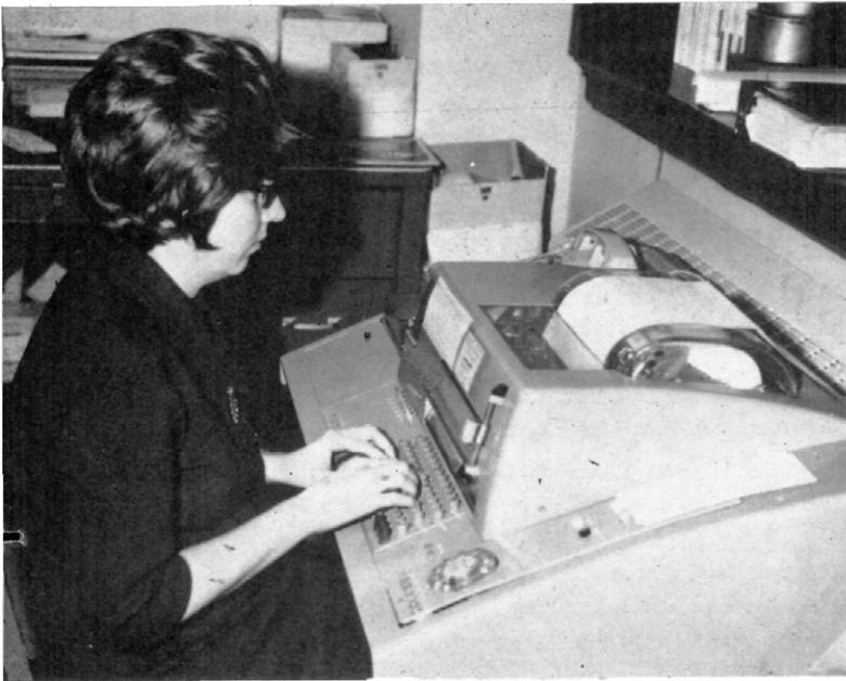
Fig. 10.—Las terminales de tiempo compartido proporcionan un acceso rápido a los ordenadores para procesar y almacenar los datos obtenidos en las prospecciones.
