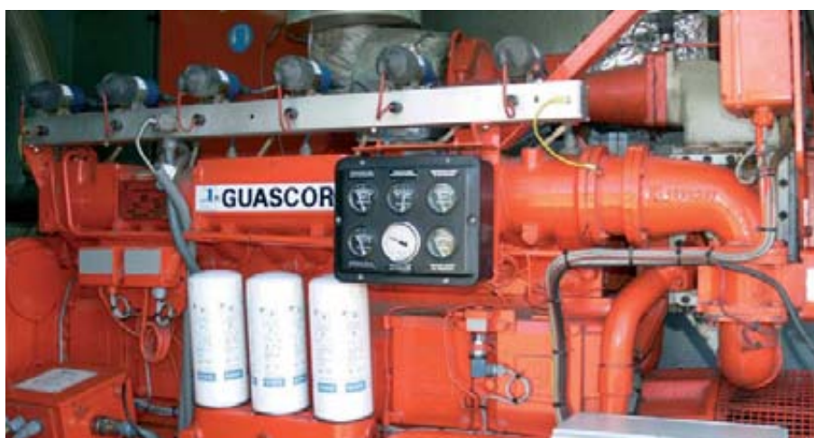
Motor de generación eléctrica desarrollado para biodiésel. Foto: Guascor Power I+D.
