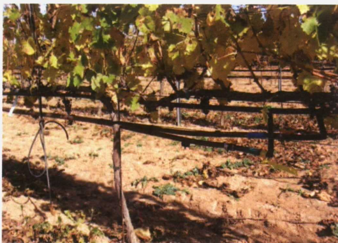
Tuberías para riego tradicional y riego PRD.
