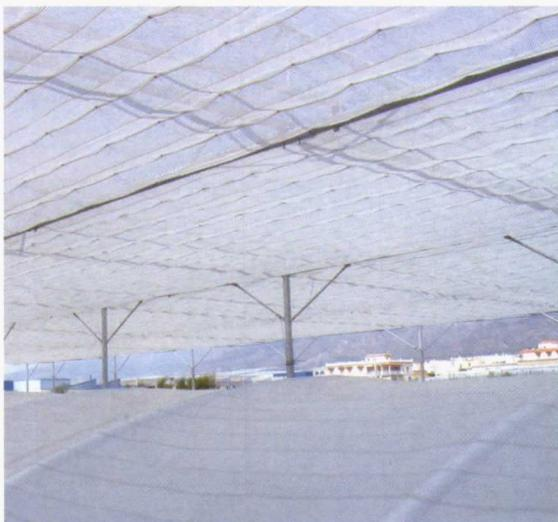
Foto izquierda. Detalle de la malla extendida sobre la cubierta del invernadero.
