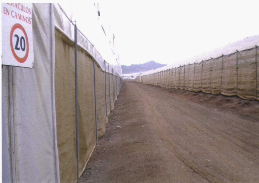
Un correcto cerramiento en los invernaderos tiene una gran importancia en el control de plagas.
