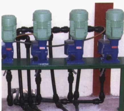
Foto 1. Bombas inyectoras de fertilizantes que permiten la regulación de las dosis a aplicar durante la campaña de fertirrigación.
