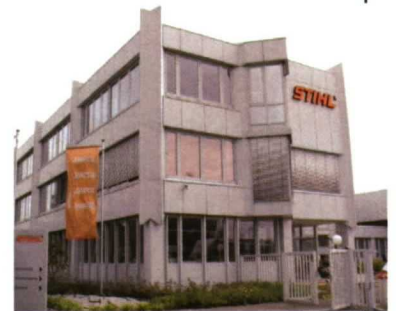
Fábrica de piezas de magnesio en Prüm.
