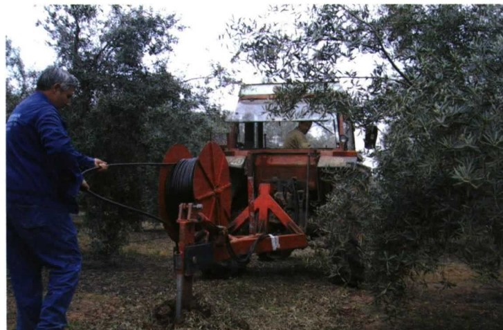
Instalación de una tubería con gotero integrado para riego subterráneo. Este sistema permite reducir pérdidas de agua por evaporación, muy interesante en condiciones de escasez de agua.
