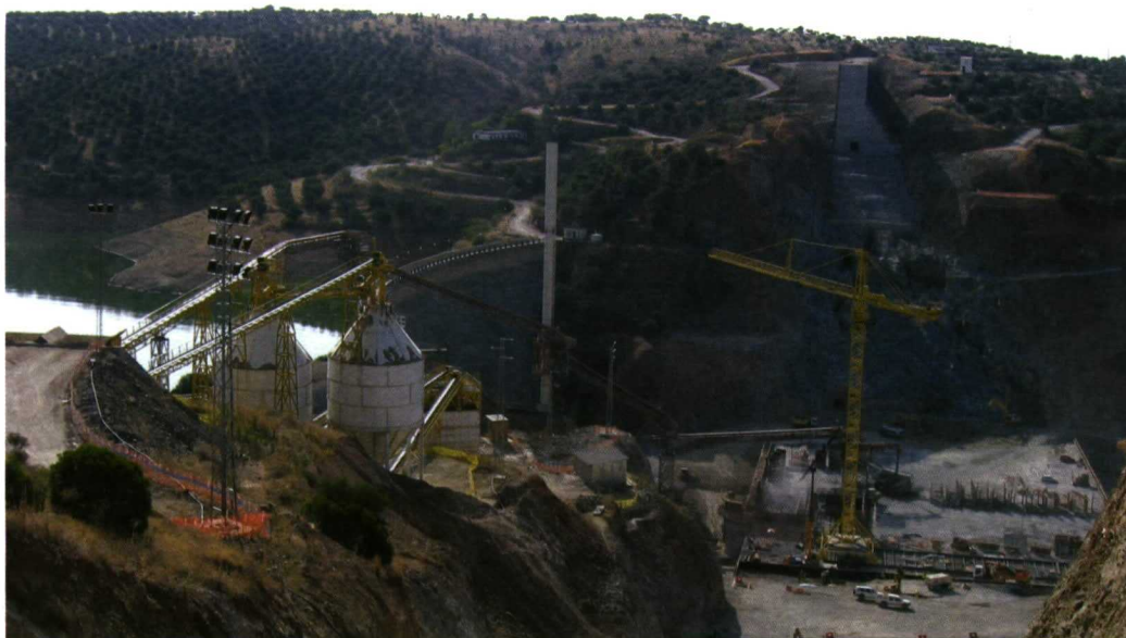
El uso racional del agua, unido al aumento de la capacidad de embalse debe contribuir a un descenso del déficit estructural existente en la cuenca del Guadalquivir. La foto muestra las obras del pantano de La Breña (Córdoba).
