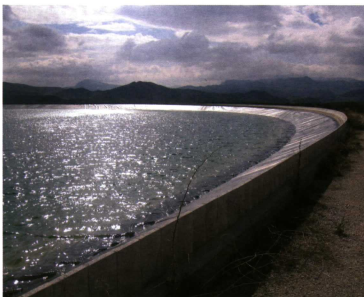
Balsa de regulación de una comunidad de regantes de la provincia de Jaén, donde se almacena agua cuando no es demandada por otros cultivos (invierno), para ser utilizada a lo largo de la campaña de riegos.
