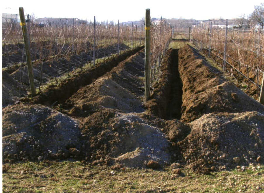
Zanjas a 50 cm de profundidad para instalación de riego subterráneo.
