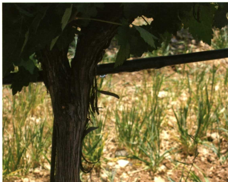
Detalle de una gota de agua en una tubería portagotero aérea.
