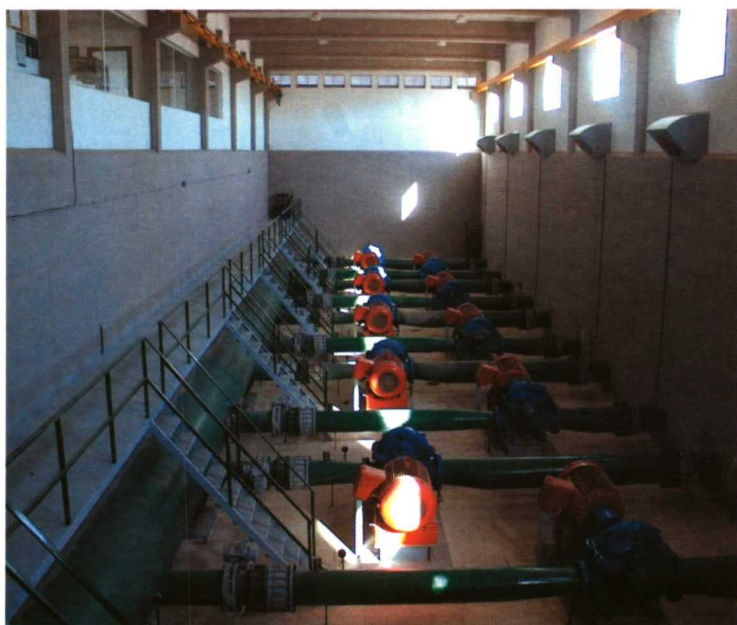
Los picos de demanda de agua de riego, en parte debidos a un aumento de la evapotranspiración, pueden tener un efecto importante en las redes de riego actuales.
