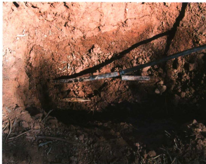
Detalle del enterrado de la tubería cinco meses después de realizada la instalación. Vemos como el agua de riego no llega a mojar la superficie del terreno, lo cual es fundamental en este sistema de riego.
