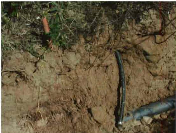
Conexión de la tubería portagoteros a los ramales de riego.
