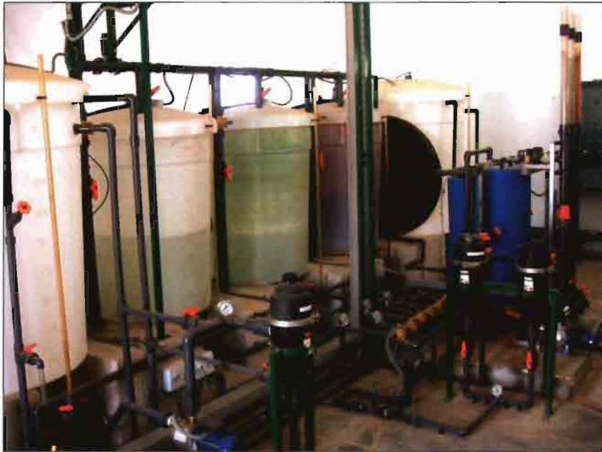
Cabezal de riego con cuba de mezclas.
