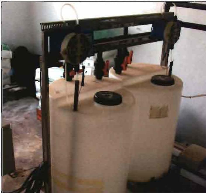
Depósitos de disoluciones concentradas, con inyectores eléctricos.
