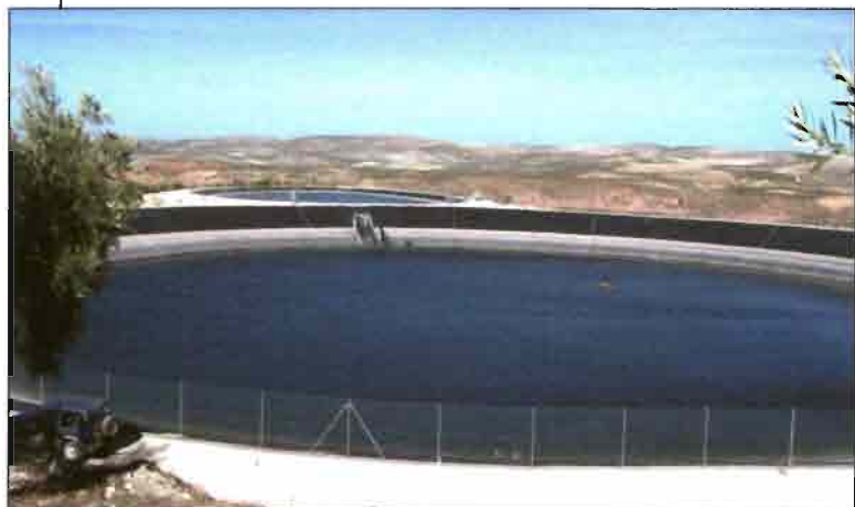
Las balsas de regulación de grandes dimensiones forman parte en la actualidad el paisaje olivarero de las zonas regables. Balsas en una comunidad de regantes de Baena (Córdoba) donde se decanta y almacena agua del río Guadajoz para riego deficitario de olivar.
