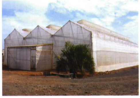
Foto 1 y 2. Estructura tradicional con cubierta de malla (izquierda) e invernadero multicapilla simétrico, con cubierta de PE y ventanas laterales y cenitales (derecha)
