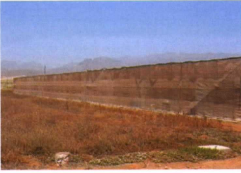
Foto 1 y 2. Estructura tradicional con cubierta de malla (izquierda) e invernadero multicapilla simétrico, con cubierta de PE y ventanas laterales y cenitales (derecha)
