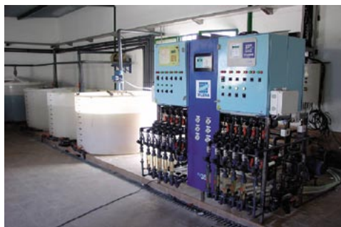
Foto 1. Detalle cabezal de riego
