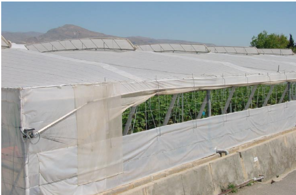
Figura 1. Fotografía del prototipo de invernadero parral multicapilla tomado como estándar para llevar a cabo las simulaciones CFD
