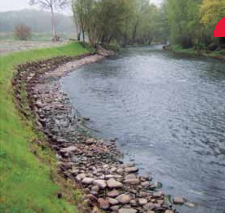
▲ Ejemplo de actuación de estabilización de márgenes con técnicas de bioingeniería: Río Sil en la Martina (Ponferrada, León). CH Miño-Sil.
